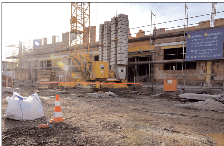
Fürs Verwaltungsgebäude im Gewerbegebiet Ohrdruf ist im November Richtfest, der Einzug soll im Sommer 2014 sein. Foto: Rainer Aschenbrenner/Curcuma Medien
