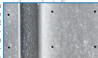
luft porentief rein. Zwischen Blech und Fassade wird ihr eingeheizt. Sie steigt deshalb in den vielen kleinen Kanälen auf. Am oberen Ende der Konstruktion wiederum ist ein Lüfter installiert. Der erzeugt bei Bedarf Unterdruck und saugt so die angewärmte Luft ins Gebäudeinnere – zum Zwecke des Heizens, Lüftens oder Trocknens. In der Halle verteilt dann ein Rohr unter der Decke mit diversen
